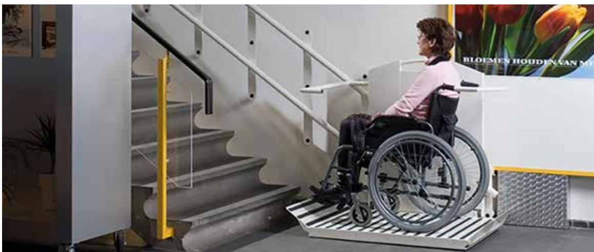
Esempio di realizzazione servoscale con piattaforma
